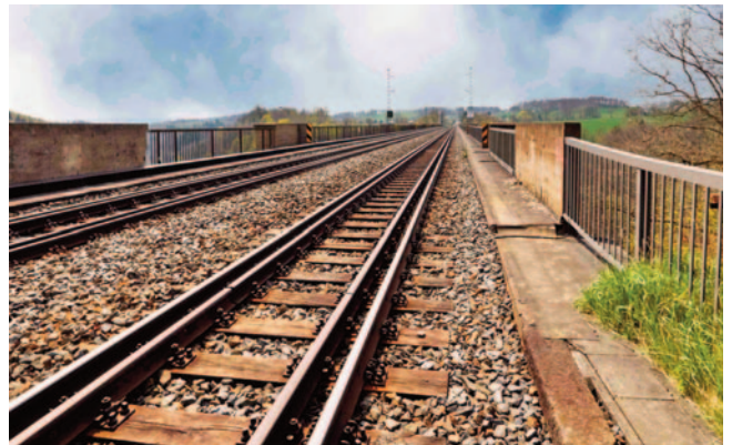
Fertigstellung neue Fahrbahnwanne
